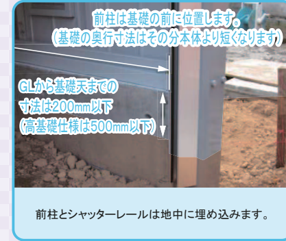
※アンカーボルト(ワッシャー1枚、ナット2個含む)は先行出荷が可能です。ご希望の際はお問い合わせください。 アンカーボルトはM10×160です。M12(市販品)も使用出来ますが、クリアランスに余裕が無い為、より本体施工精度が求められます(M12アンカーボルトをご使用の際は、ワッシャー(1枚)とナット(2個)もご用意ください。)
